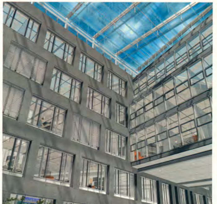
Glasüberdachte Atrien im Hauptgebäude Glass roof atrium in the main building
